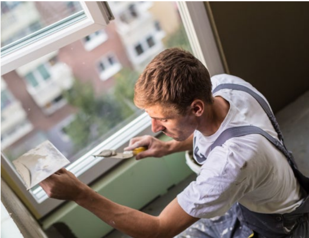
Sanieren und bauen! Sozialwohnungen braucht das Land
