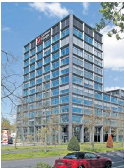
Ein Beispiel wie es gehen kann – das SachsenEnergie-Hochhaus
