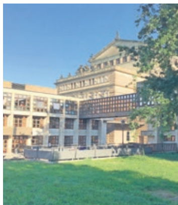
Blick über den möglichen Bauplatz
