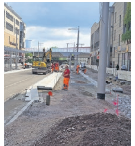
Die Zentralhaltestelle auf der Kesselsdorfer Straße im Bau
