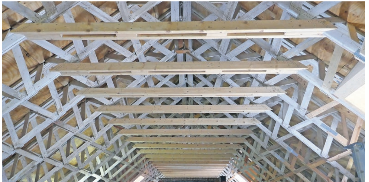
Holzkonstruktion des Kroher-Dachstuhls im Kasernenflügel Hellerau
