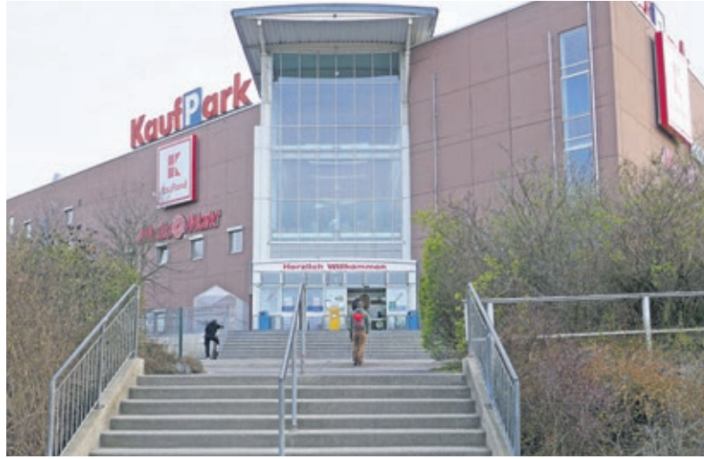
Der Kaufpark in Nickern im gegenwärtigen Zustand
